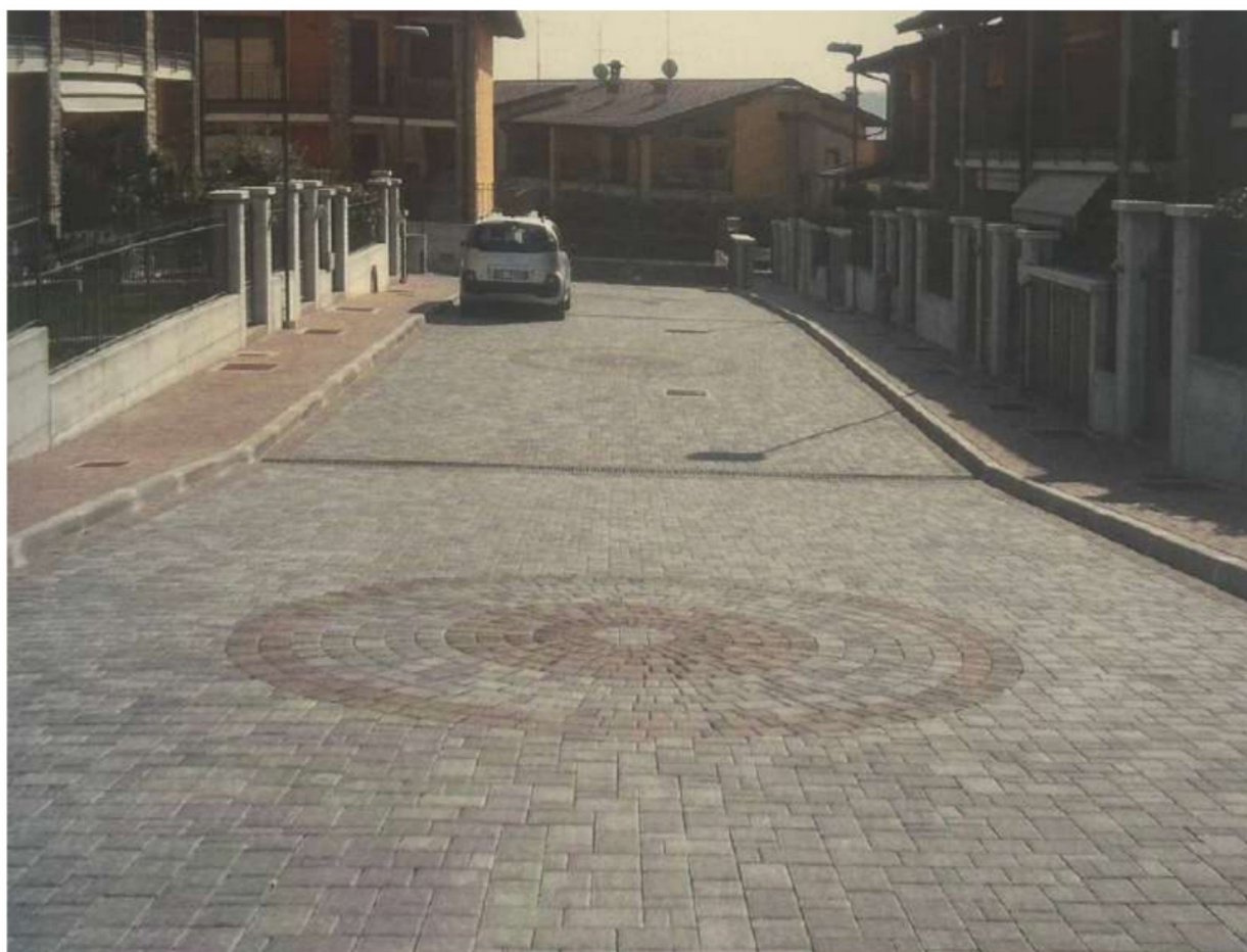
Proteo Mix Ardesia posa a giunti incrociati con rosone Mix Porfido
