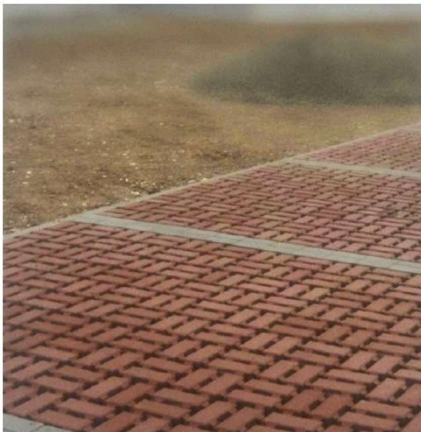
Vega Dren Rosso posa a cestello
