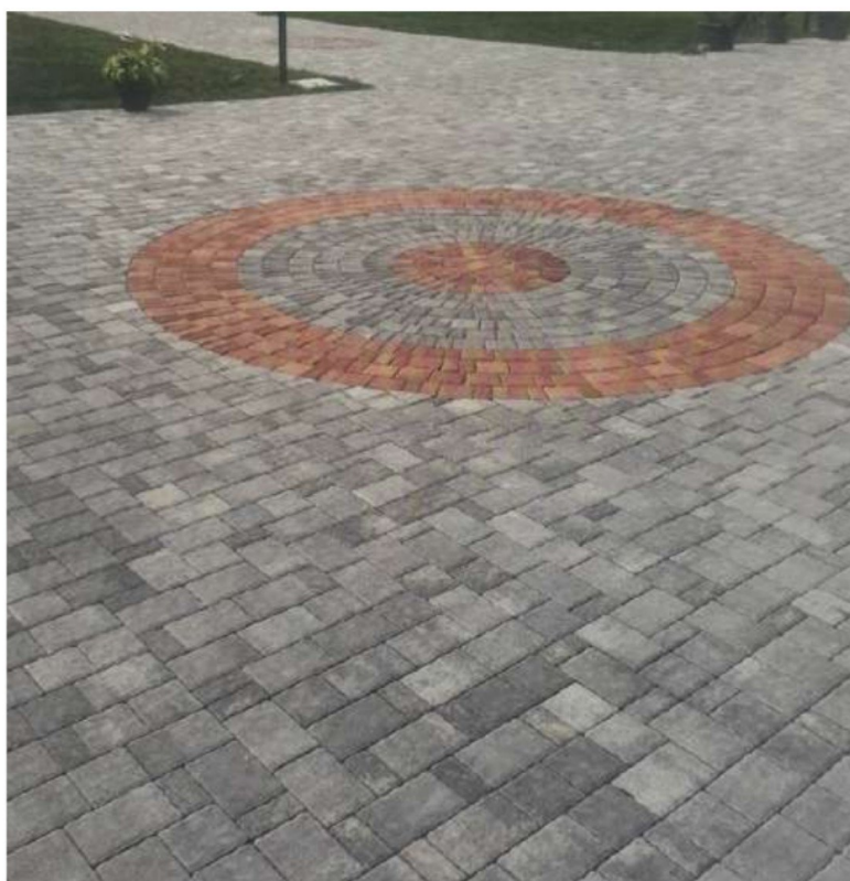
Proteo Mix Ardesia posa a giunti incrociati con rosone Mix Porfido
